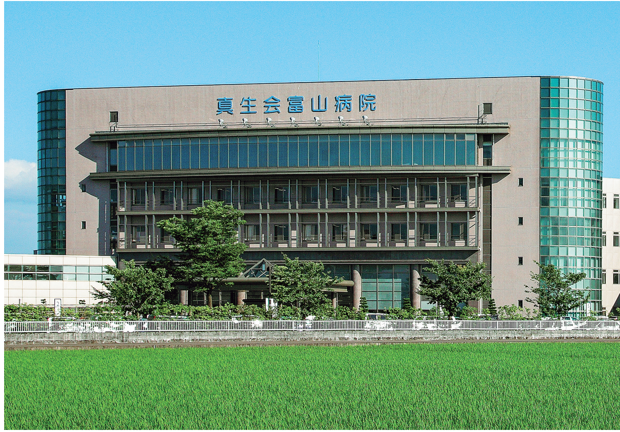
真生会富山病院（富山県射水市）
