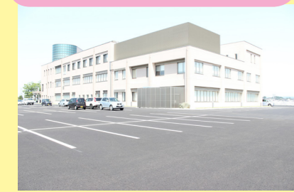
透析室の増床、眼科の拡張、心療内科の移転などが行われ、駐車場も整備されました。
